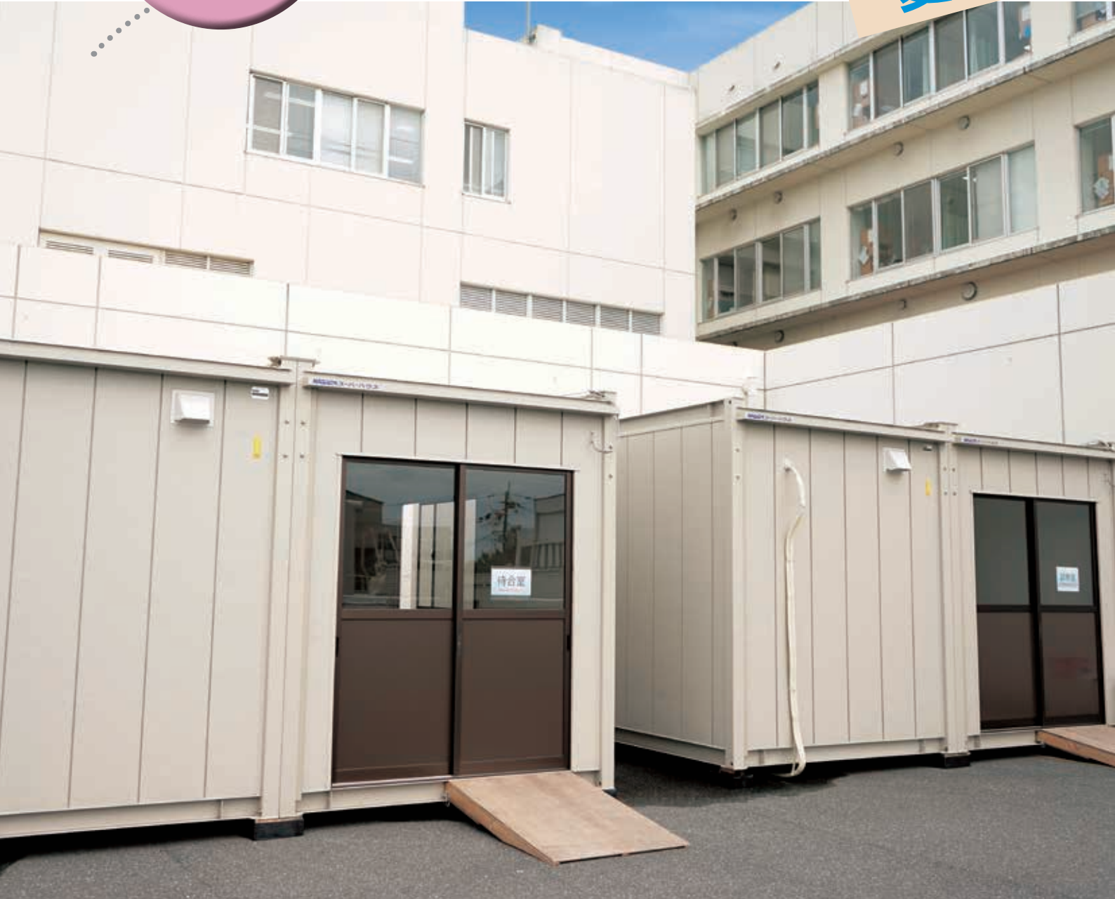
救急車搬入出入口北側に設置された、空調完備の発熱外来専用待合室と診察室
